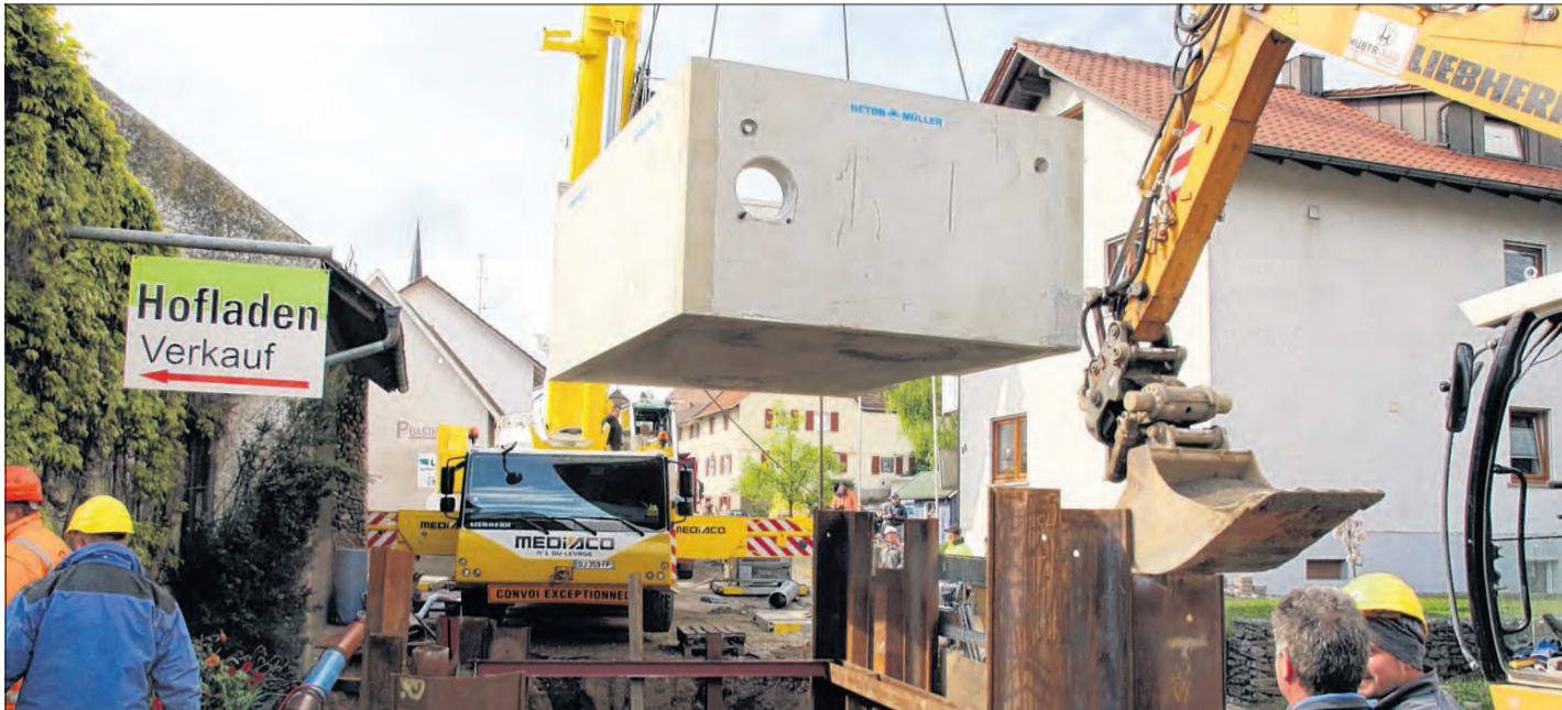
Maßarbeit an Planung und Ausführung erlebten konnten viele Mösbacher Bürger erleben, als das große Regenüberlaufbauwerk angeliefert wurde, hier das eigentliche Bauwerk mit 46 Tonnen Gewicht. Foto: Roland Spether
